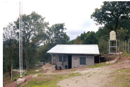
Nueva Casa de Transmisores, Aldea Las Nubes, cerca del cerro Cantagallo
